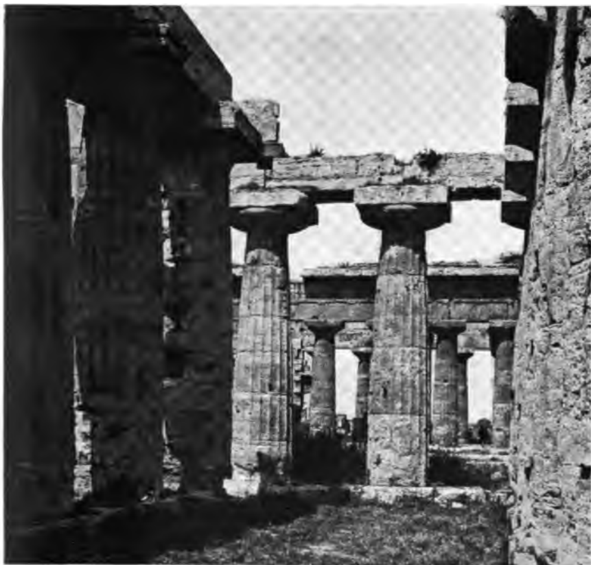
Fig. 23. — Chapiteaux de colonnes et ante du monument dit la Basilique à Perstum. Profil d'ante en forme de gorge égyptienne. Décor linéaire de la colonne dorienne, interprétant par les cannelures un faisceau de tiges et par les annelets les ligatures de ce faisceau.
